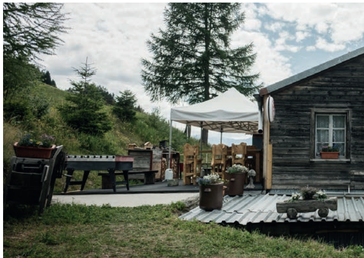
Das Berggasthaus Chäller wurde aufwendig renoviert.
